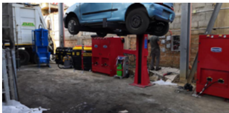
Area attrezzata LIFE De-Bay in fase di assemblaggio
